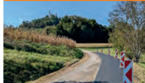
Straßen- und Wegebau Gemeindestraßen saniert
