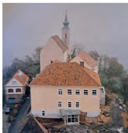
▲ Das Schulhaus in Straden 7 bei der Sanierung im Jahr 1992
